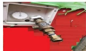
Un dispositivo de prevención de reflujo instalado en el exterior de la unidad para la conexión de la línea de agua pública
